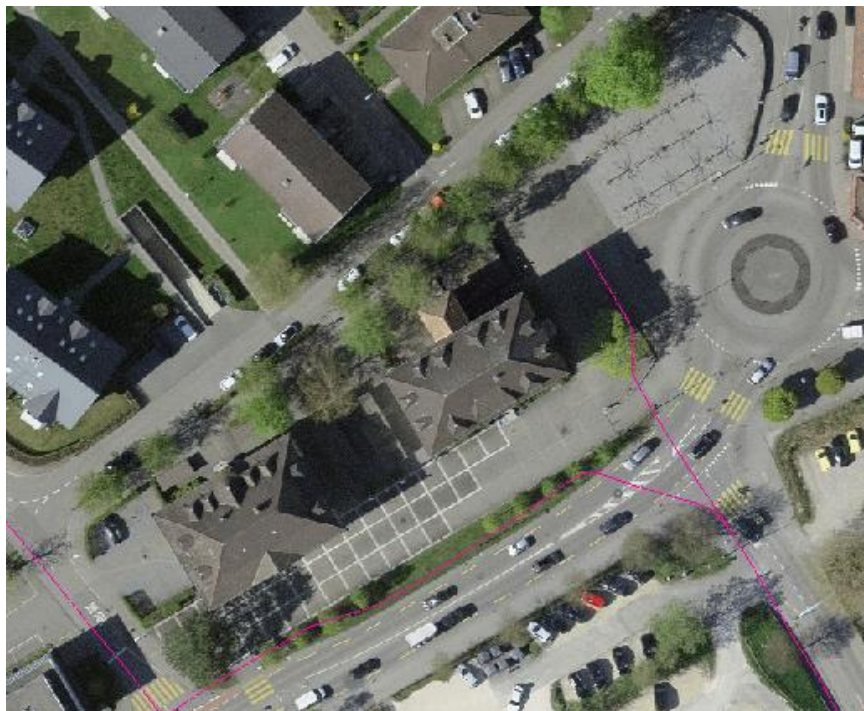
Abb.33 Gemeindehaus, Bezirksschule, Luftbild (Quelle Infogis)
